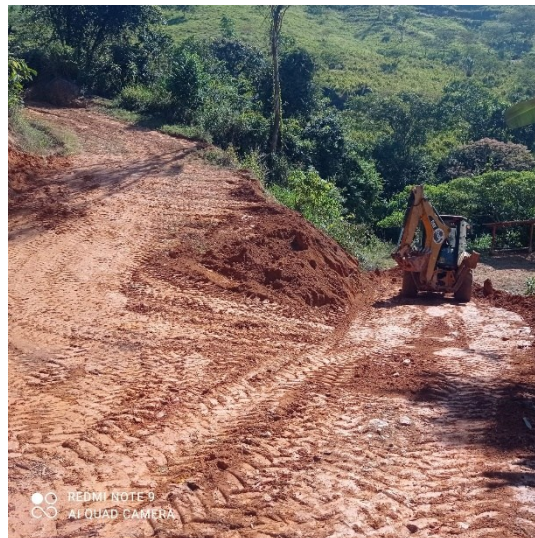
Imagen 17: Trabajos de limpieza y mantenimiento vial de las diferentes vías de acceso a la parroquia y sus barrios con el apoyo de la máquina retroexcavadora.
