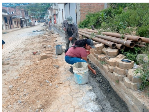
Imagen 2: Adecuación de cunetas en la calle Loja con el apoyo del personal del GADP y moradores.
