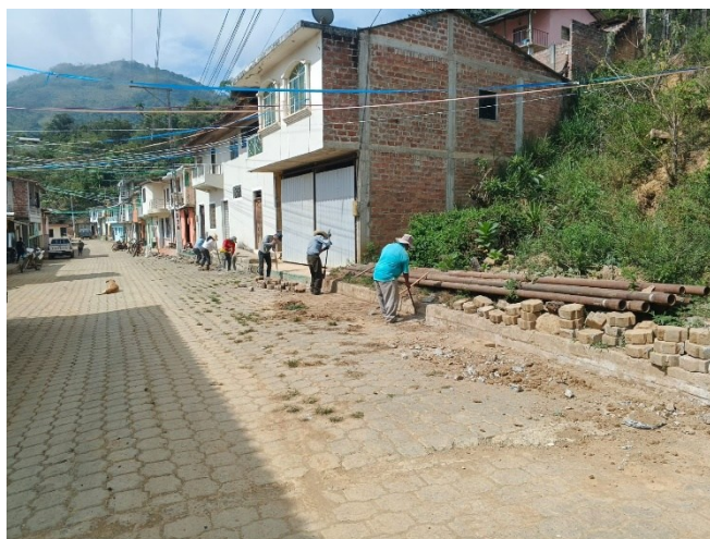
Ilustración 11: Adecuación de cunetas en la calle Loja de la parroquia con el apoyo de moradores del sector.
