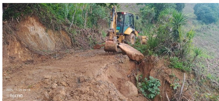
Ilustración 6: Trabajos de mantenimiento vial de las diferentes vías de cada uno de los barrios
