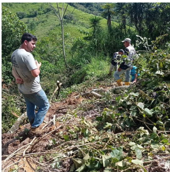
Ilustración 14: Desbroce de costado de vía del barrio Valle Hermoso
