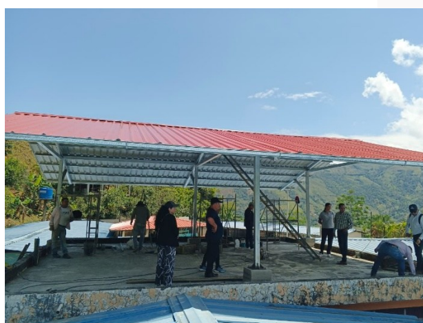
Ilustración 12: Verificación del avance del proyecto de mejoramiento del aula de computo de la Unidad Educativa Edison
